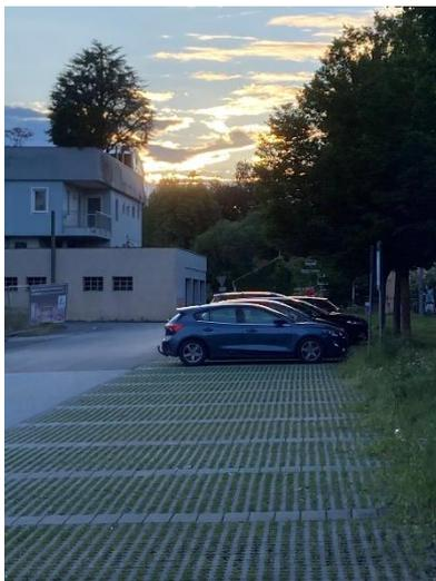
Versickerungsfähige Parkplätze mit Rasengittersteinen wie entlang der Allee werden von der Gemeinde schon seit vielen Jahren umgesetzt. Bei großen Niederschlagsmengen tragen diese zu einer lokalen Versickerung bei und bieten gleichzeitig die Möglichkeit der [Evapotranspiration](#) an heißen Tagen.
